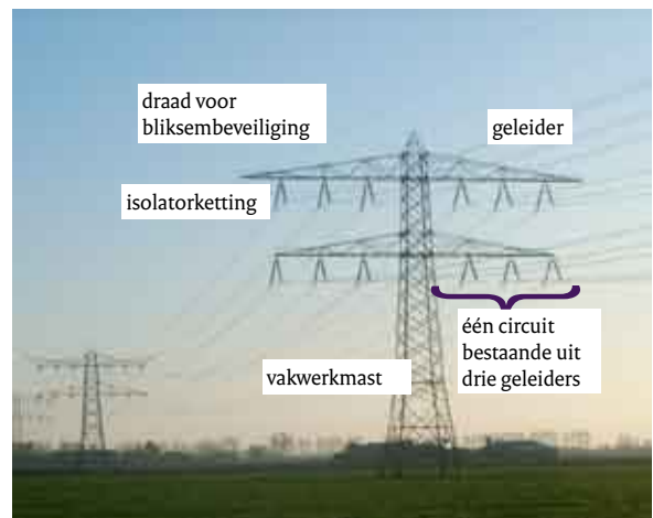
Voorbeeld van een 4-circuits vakwerkmast.
