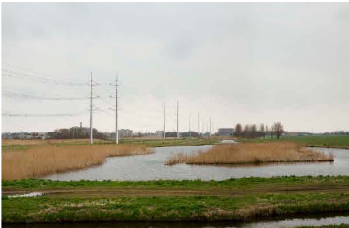
Figuur 4.12 Wintrackmast zoals ontworpen voor Randstad 380kV
